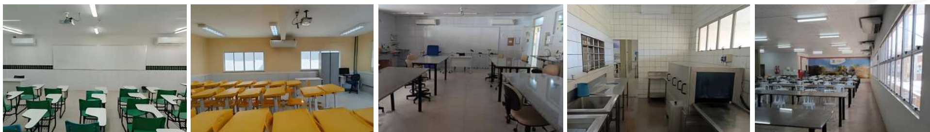
Figura 58 - Ambientes climatizados por condicionadores de ar do modelo split
